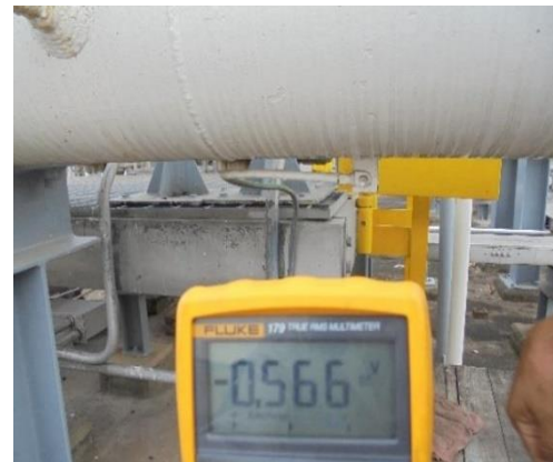
รูปที่ 2-14 ตัวอย่างงานบำรุงรักษา Insulation Joint
