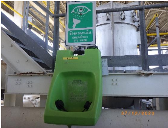
รูปที่ 2-20 อ่างล้างตาและล้างตัวฉุกเฉิน
