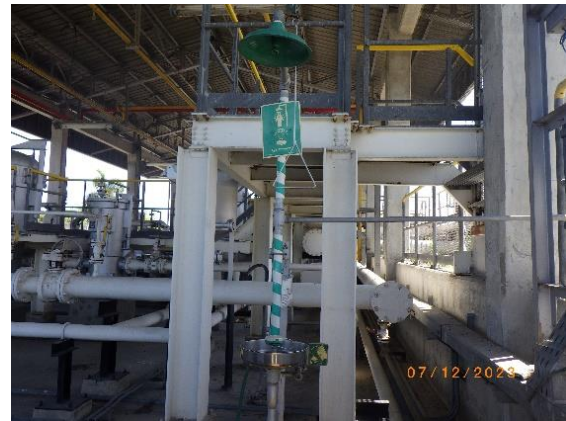
รูปที่ 2-20 อ่างล้างตาและล้างตัวฉุกเฉิน
