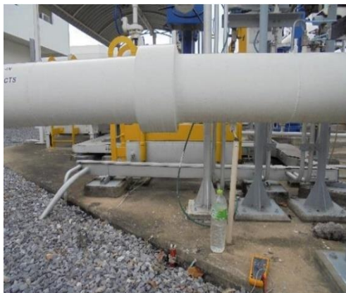
รูปที่ 2-14 ตัวอย่างงานบำรุงรักษา Insulation Joint
