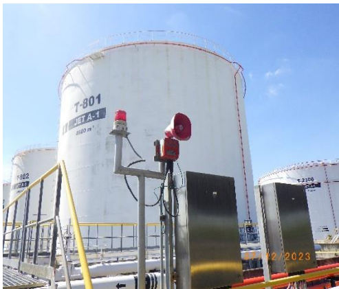
รูปที่ 2-18 (ต่อ) ระบบตรวจสอบ ตรวจจับ และสัญญาณเตือนภัยแบบอัตโนมัติ
